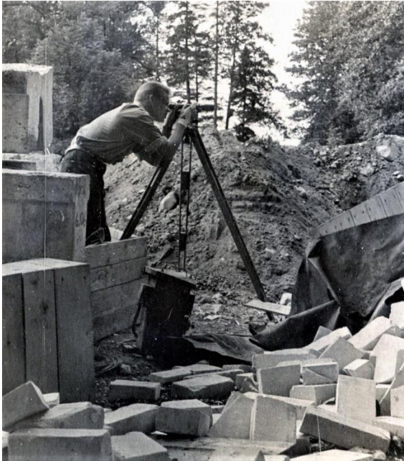
Pildil elektrijaama kalda kindlustamine.
