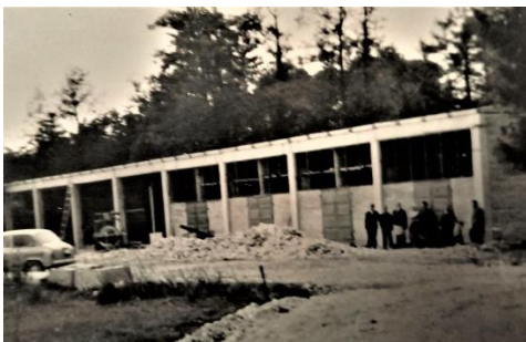
Pildil meie ehitatav Kärkla elektrijaama abihoone.
